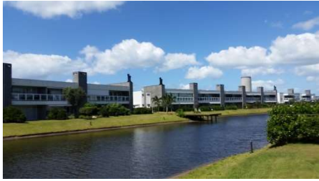
Torre 1 e 2 Fundo
